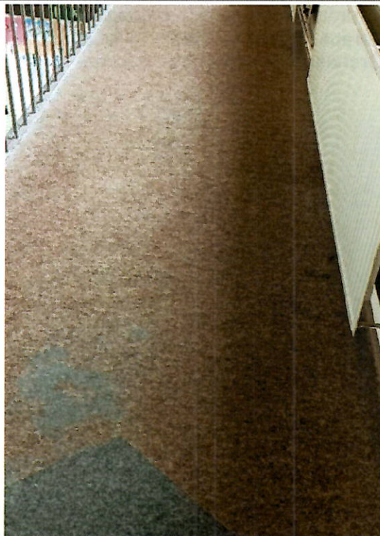
Abbildung 32 Abgenutzter Vliesboden
