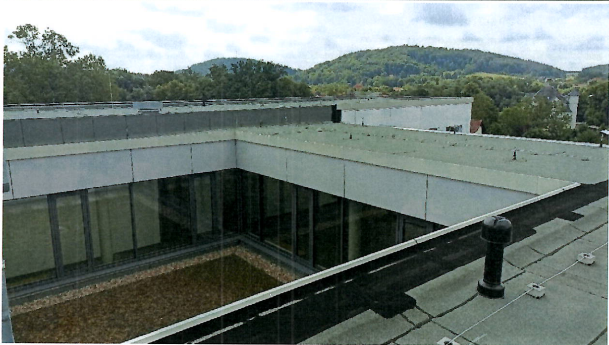
Abbildung 38 Flachdach saniertes Schulgebäude (2023)
