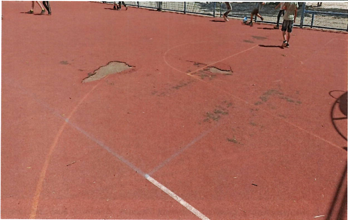
Abbildung 7 Spielfeld mit löchrigem Kunststoffbodenbelag
