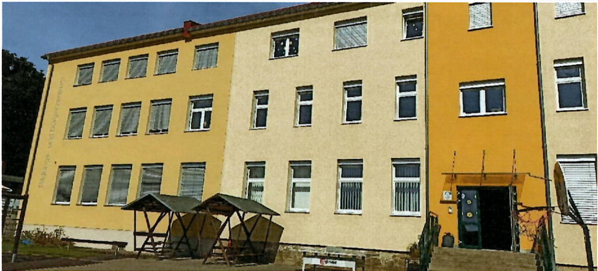
Abbildung 36 Energetisch sanierte Fassade mit Sonnenschutz (2012)
