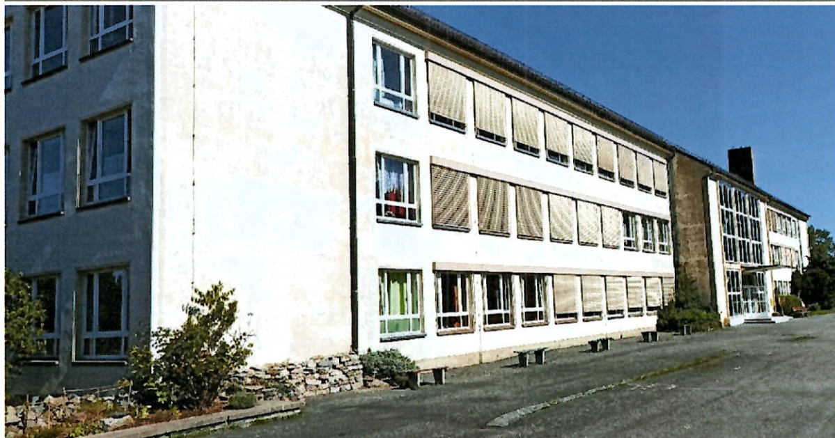
Abbildung 9 Ungedämmte Gebäudehülle
