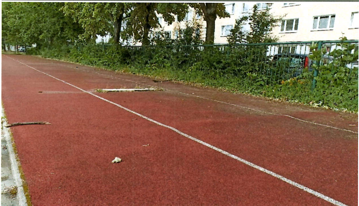
Abbildung 8 Bemooste und unebene Kunststoffbahn
