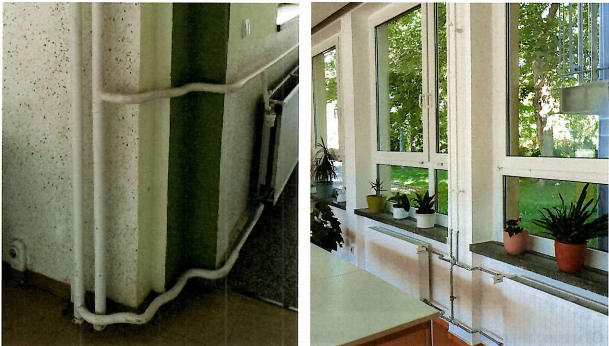
Abbildung 15 Ungedämmte Heizungsleitungen
