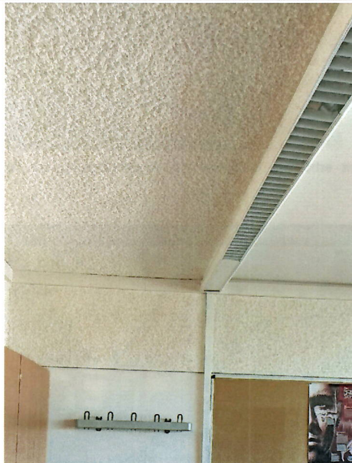
Abbildung 64 Schallschutztechnische Ertüchtigung mit Spritzputz
