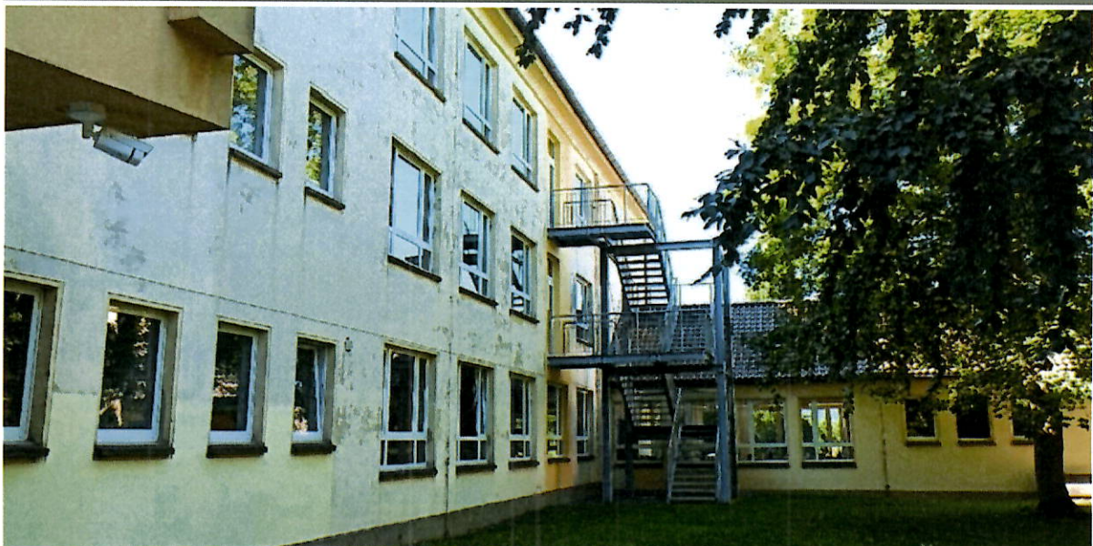
Abbildung 66 Fluchttreppenhaus an denkmalgeschütztem Gebäude
