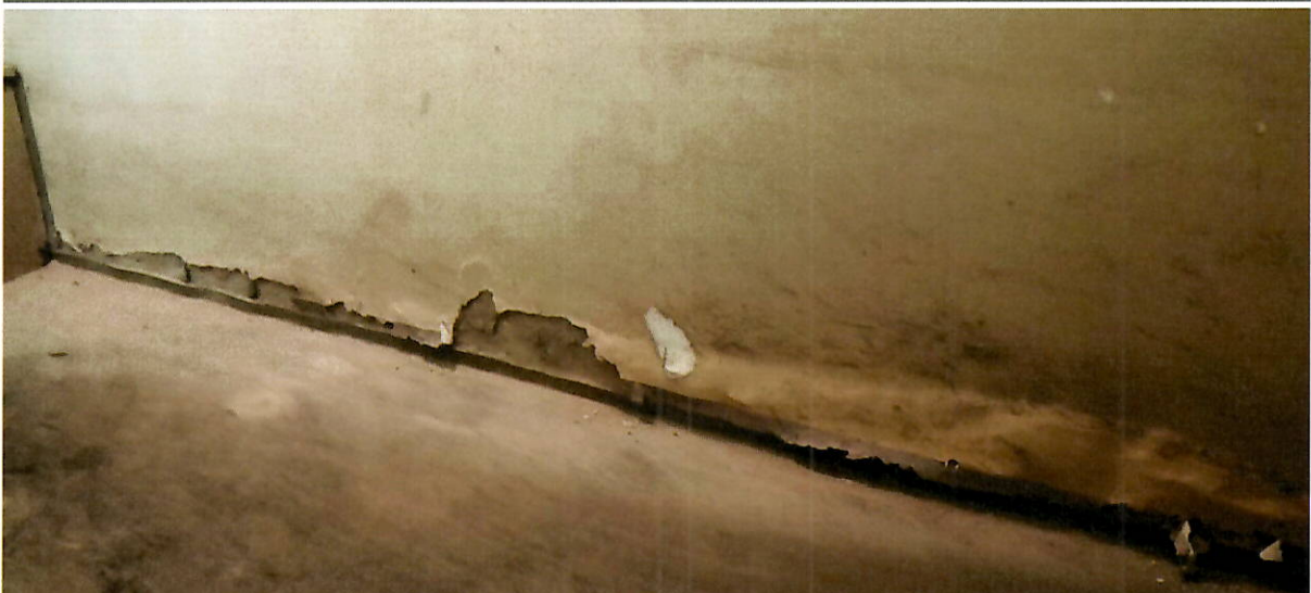
Abbildung 21 Feuchteschäden
