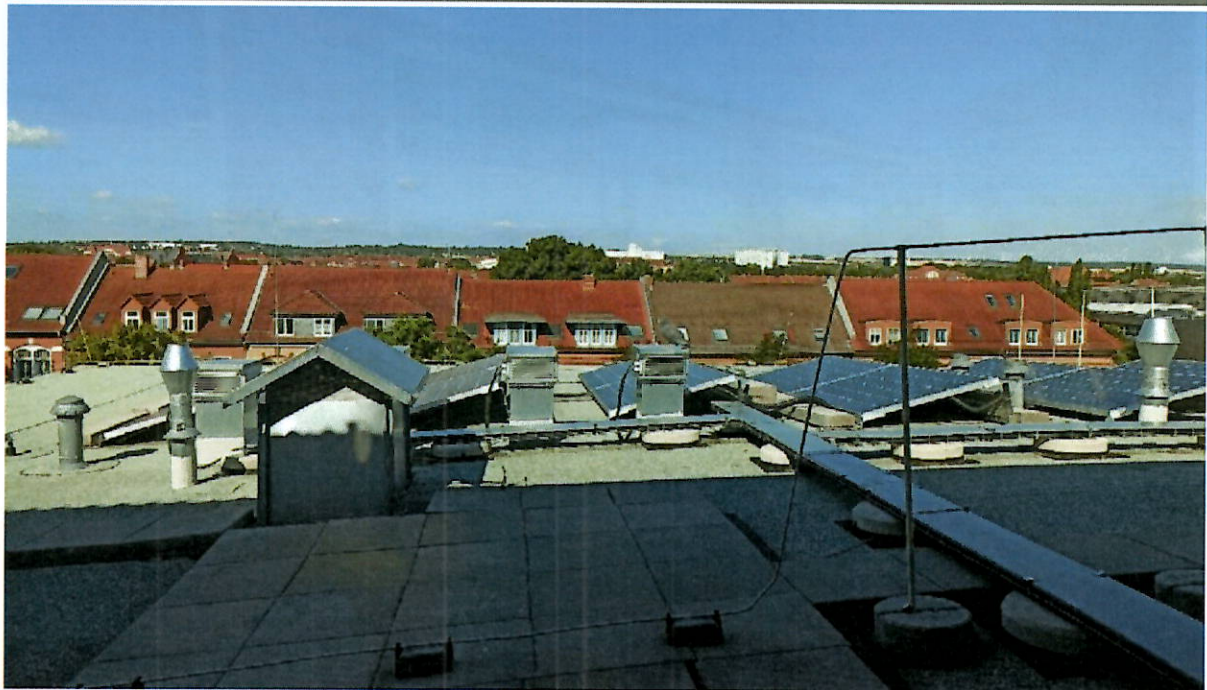
Abbildung 39 Saniertes Flachdach mit Photovoltaik-Anlage (2020)
