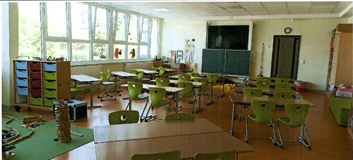
Abbildung 41 Saniertes Klassenzimmer Grundschule (2018)
