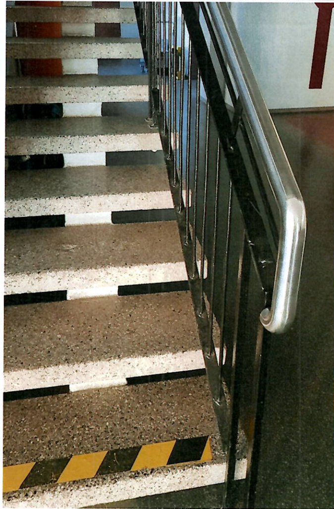
Abbildung 65 Bestandstreppe mit ergänzter Absturzsicherung
