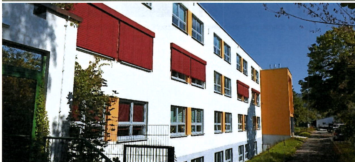
Abbildung 10 Fassade Südseite mit partiellem Sonnenschutz
