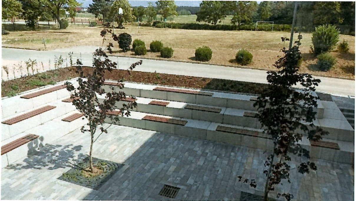
Abbildung 57 Sanierter Pausenhof Regelschule (2023)
