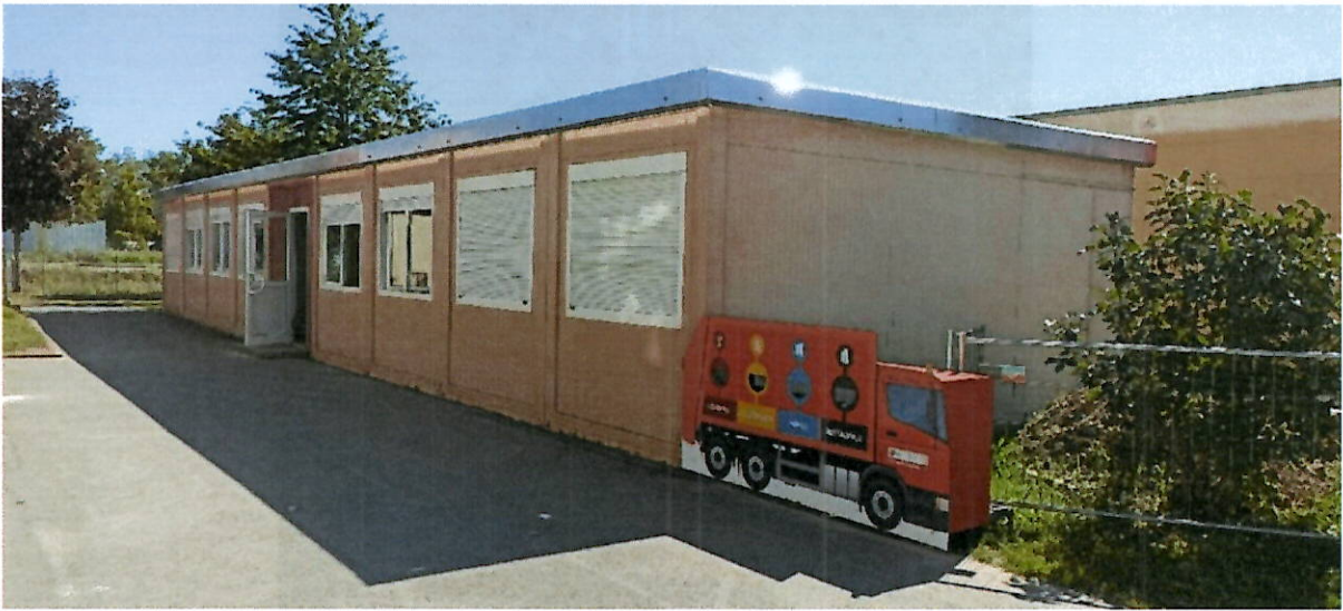
Abbildung 63 Erweiterung mittels Containerlösung (2 Klassenzimmer mit Nebenraum)
