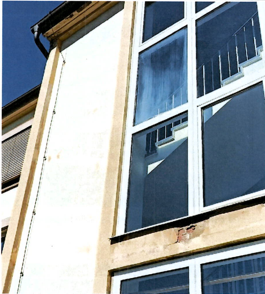
Abbildung 11 Undichte Fenster
